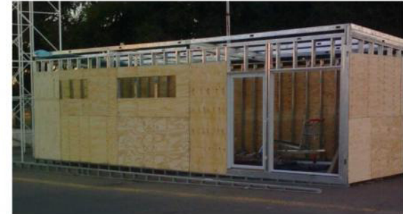
COLOCACION DE ABERTURAS
