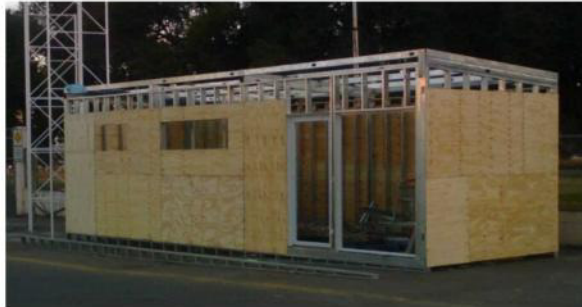
RIGIDIZACION DE LA ESTRUCTURA
